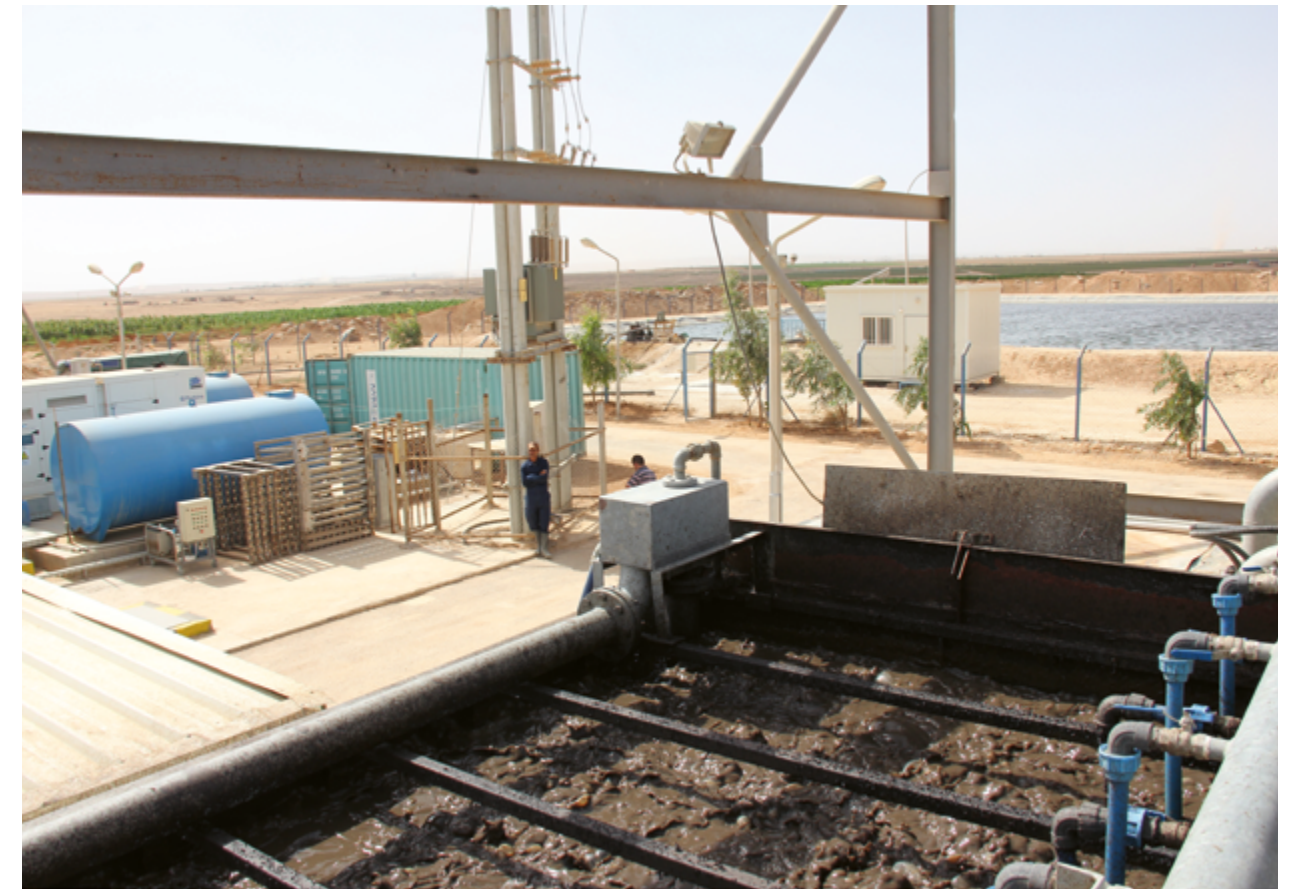
Membranbioreaktor mit anschließendem Klärteich und Wiedernutzung des geklärten Abwassers im Za'atari Camp, Jordanien
